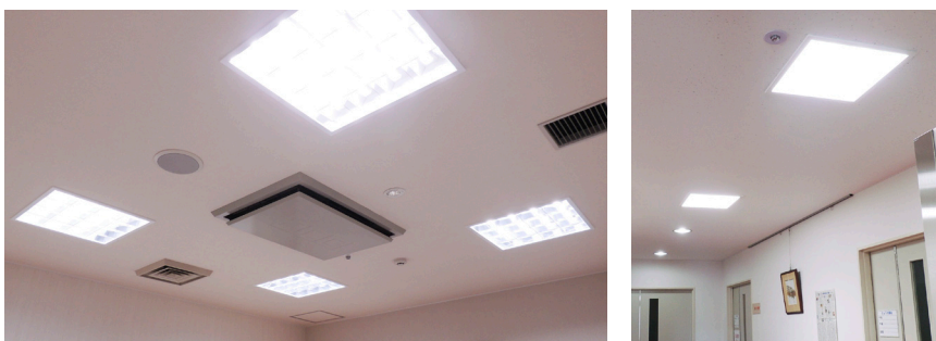
コンパクト蛍光灯は27形、36形、55形を導入。電源内蔵で省エネ効果60%以上。
