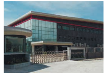
フィリピン製造工場外観
