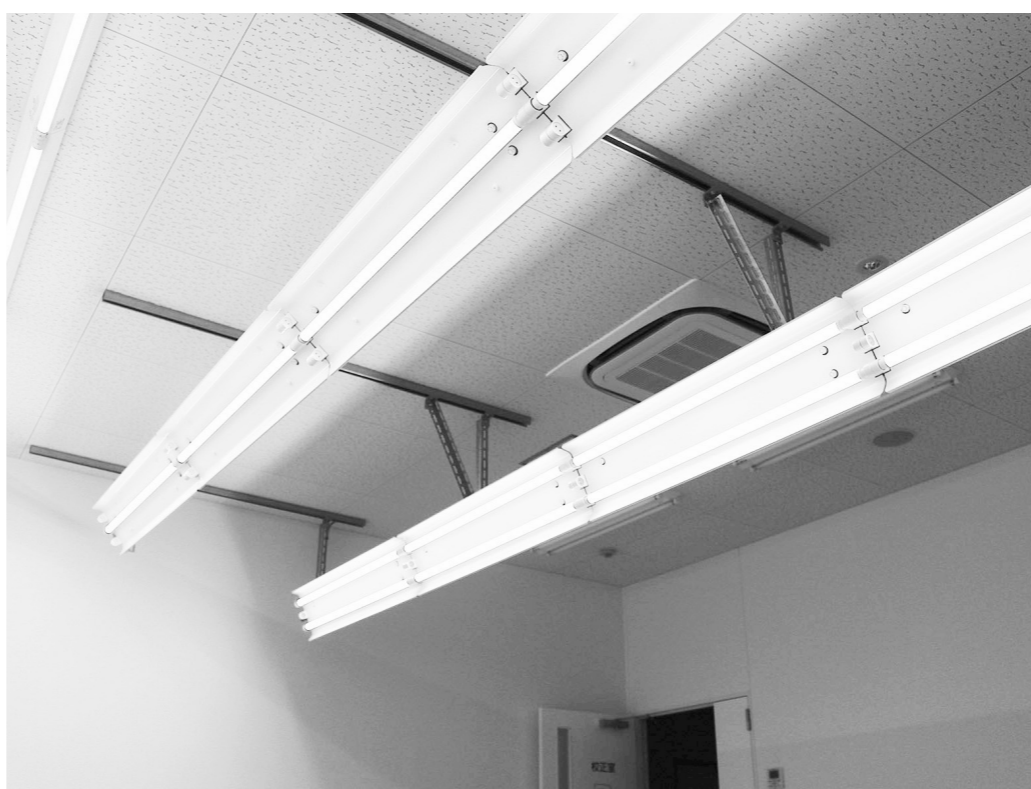
校正室に設置された演色AAA相当/Ra97を実現するエコリカLEDランプ
