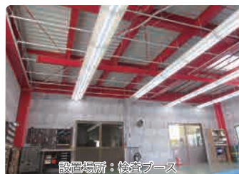
設置場所：検査ブース
